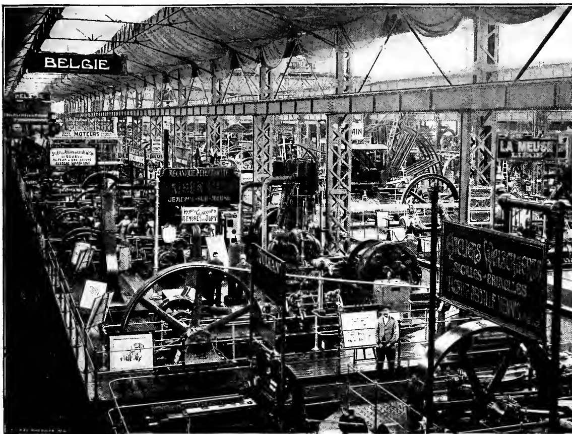
UN ASPECT DU HALL DES MACHINES.
